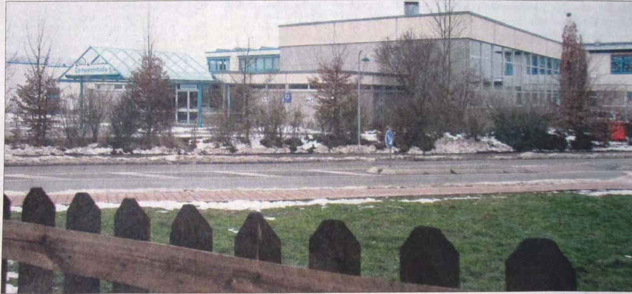
Die Sanierung der Hochdorfer Gemeindehalle ist mit 350 000 Euro der größte Investitionsposten im Eberdinger Haushalt 2010.
